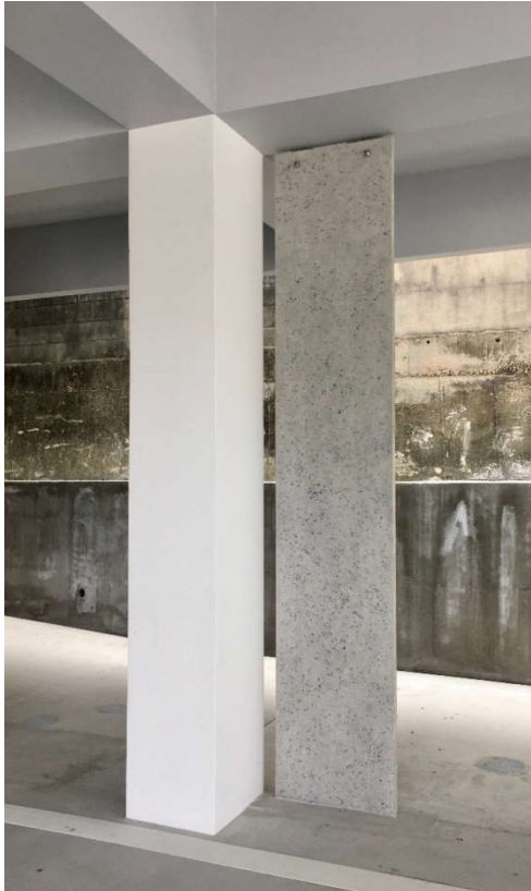
配管の目隠し壁
