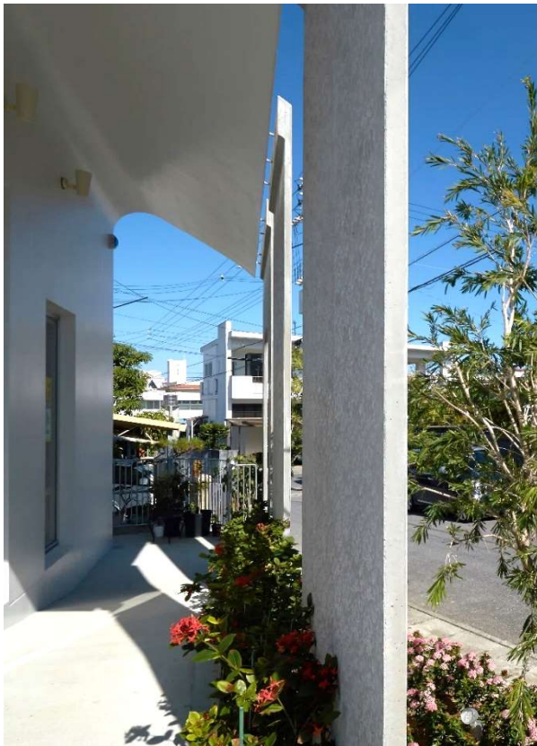
玄関前の目隠し壁兼雨樋
