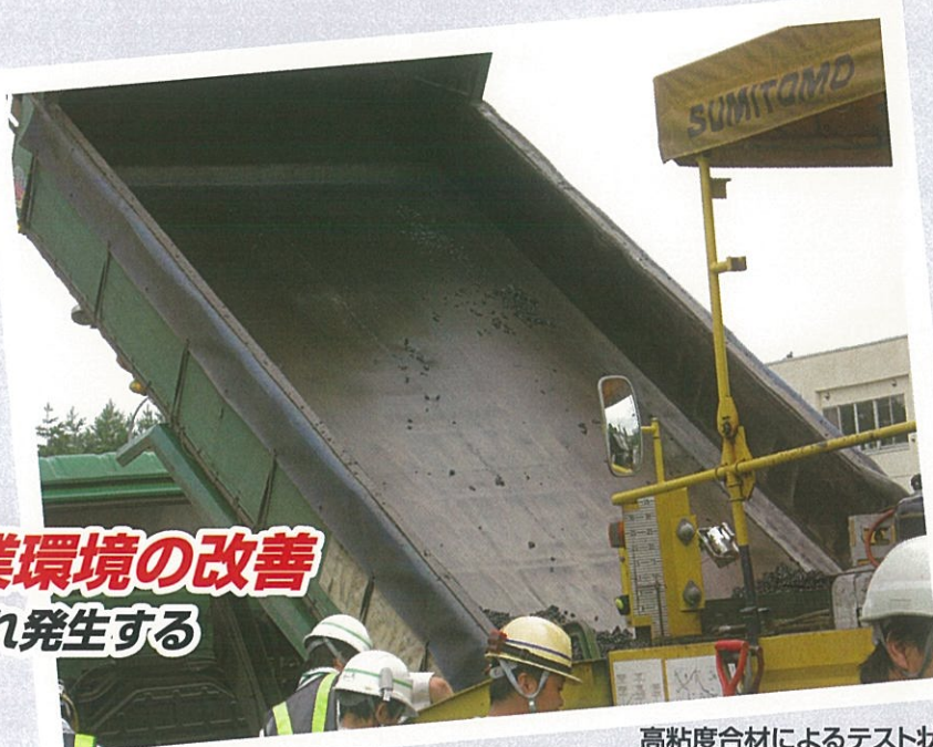
高粘度合材によるテスト状況
