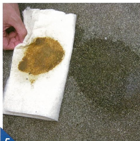
浮き上がった油を再び 吸着マットで拭き取る
