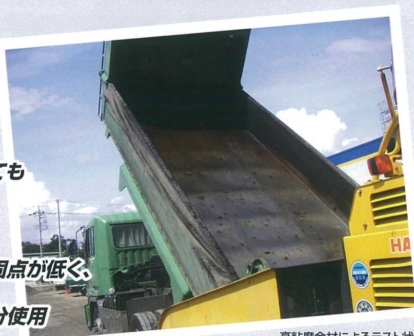
高粘度合材によるテスト状況
