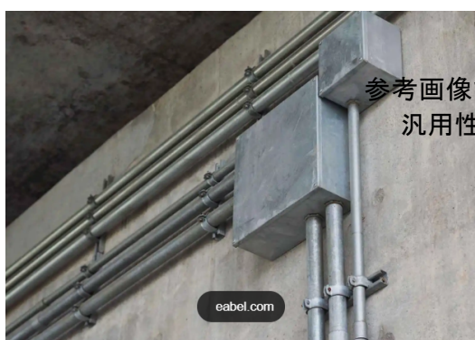
壁面の高圧電線パイプ & ジャンクションボックス(配管)
