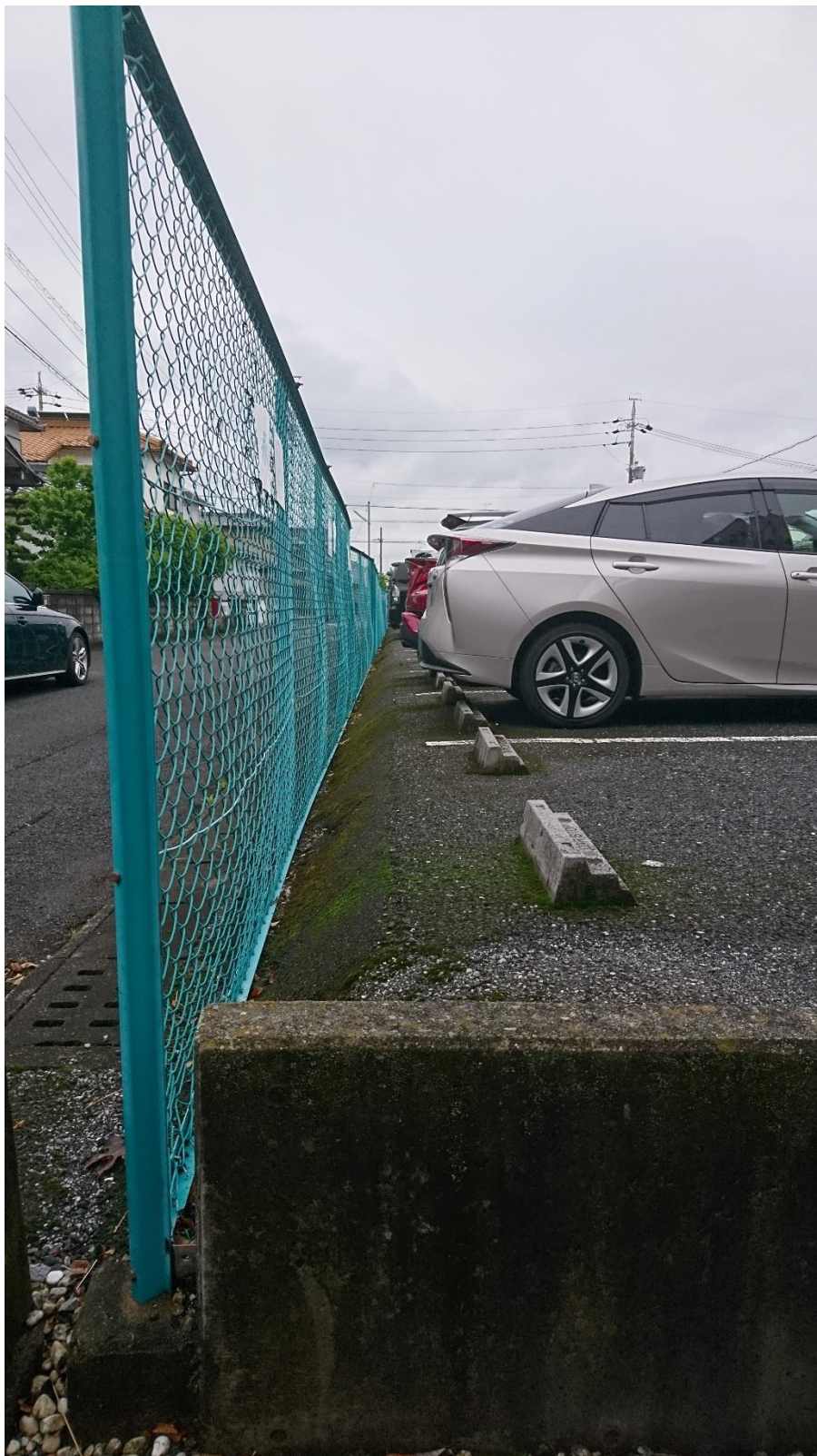
東側フェンス周辺
