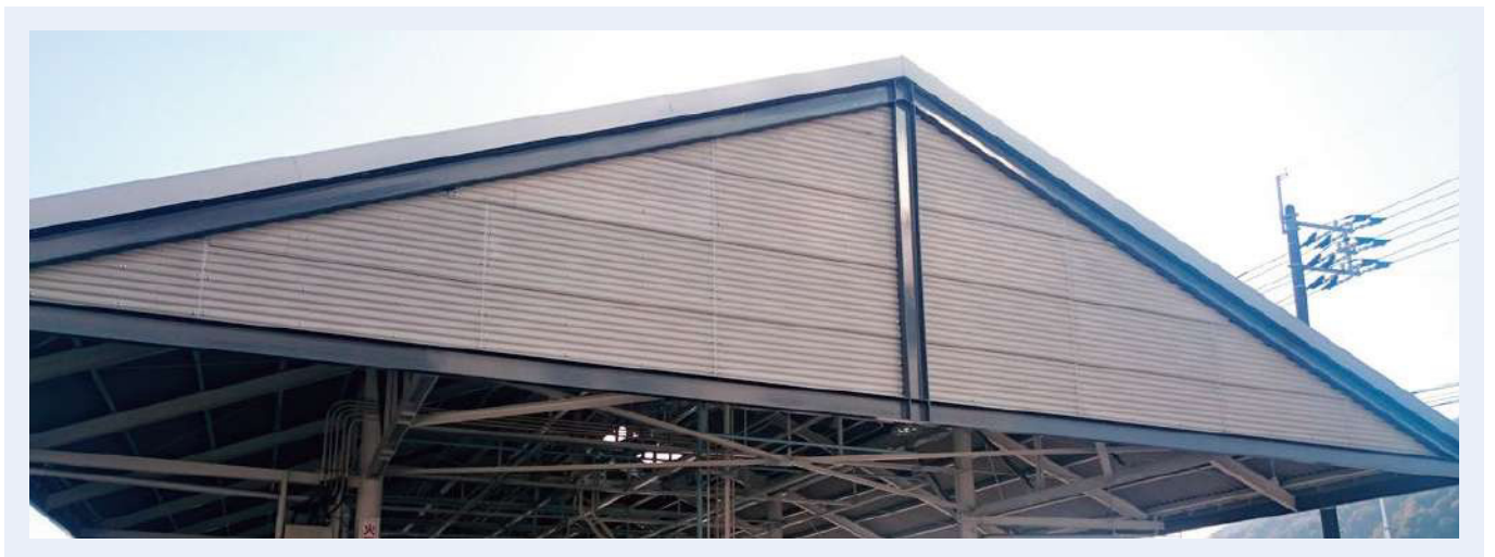
小波スレート縦張り施工例
