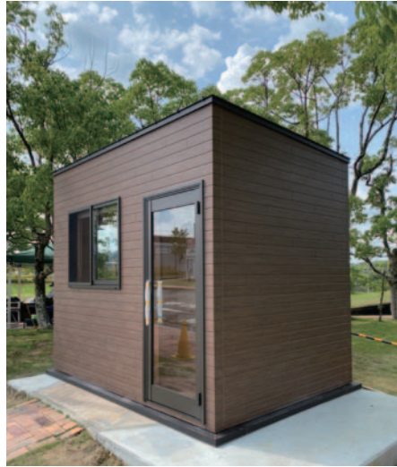
神戸市 工場守衛室
