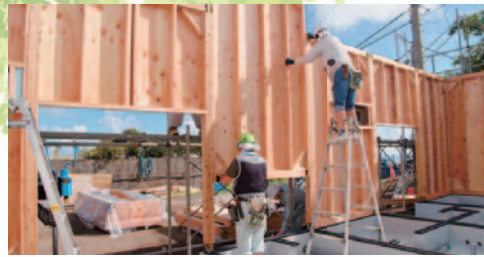
外壁パネルの施工
