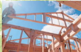
小屋組パネルの施工
