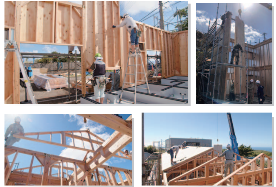
「在来軸組パネル構法」の建て方
