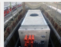
マンホール工事（埋設）
