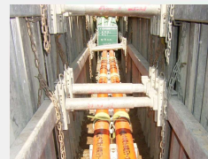
管路工事（埋設管路）
