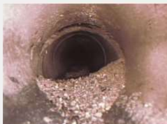
空孔管路のカメラ点検
