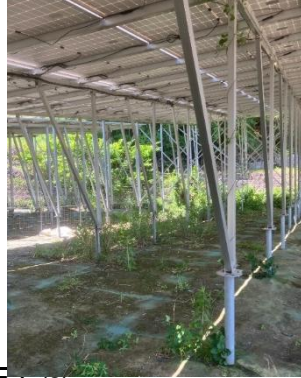
架台② 異常なし
