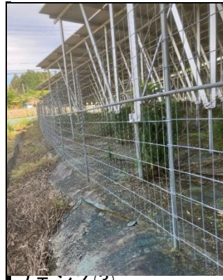
フェンス③ 側面は今は草が生えてないがこれから伸びる可能性があります。
