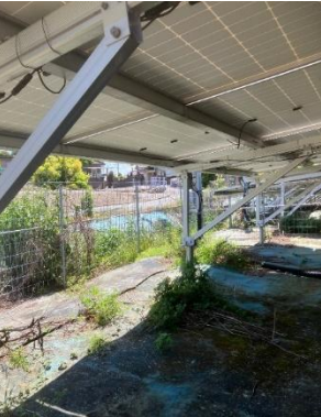
架台④ 異常なし
