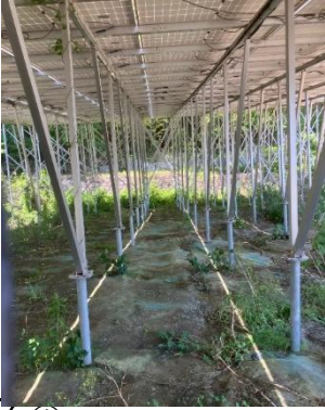
架台① 異常なし
