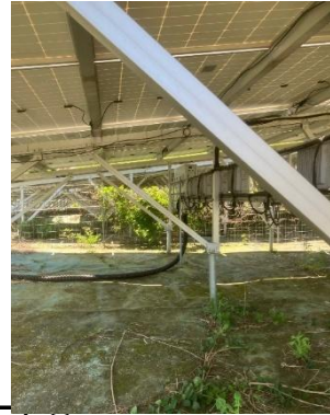
架台⑤ 異常なし
