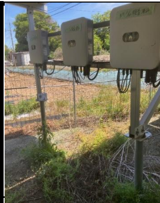
パワコン① 異常なし。
