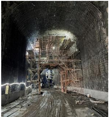
上流入り口補強工事
