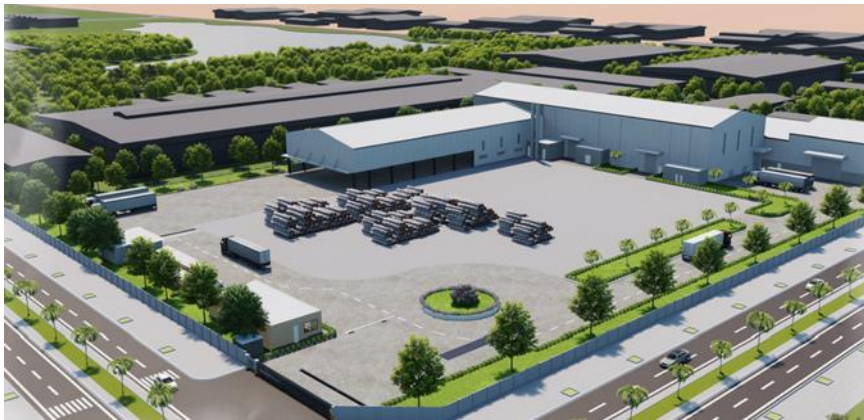
トゥエンクアン省 ペレット工場
