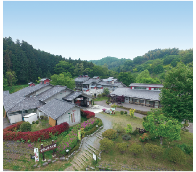
甘楽ふるさと館(施設全景)
