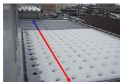
【屋根上の状況】
