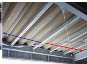
【天井面の状況】
