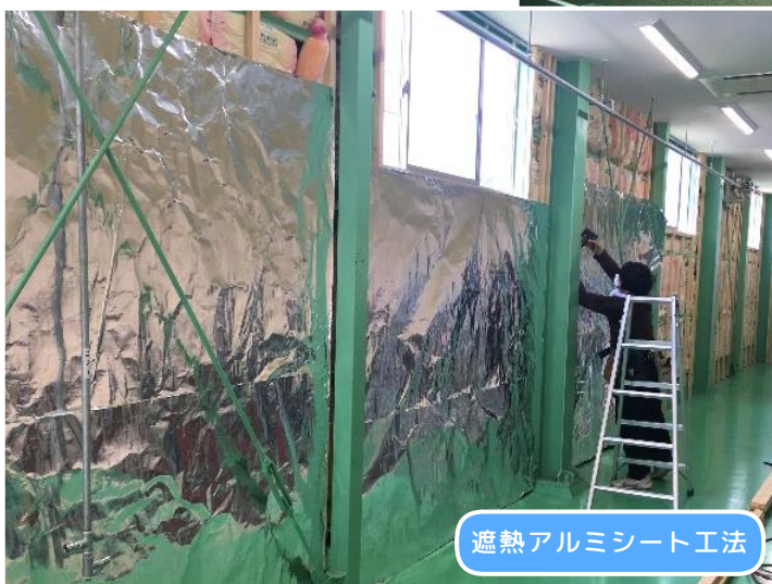
屋根遮熱シート工法
