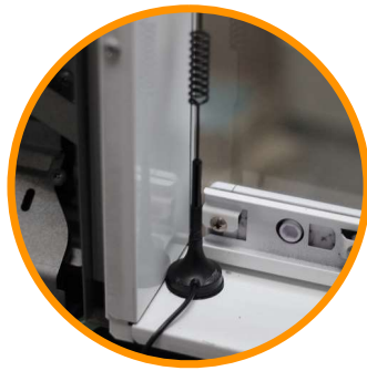
アンテナを設置
