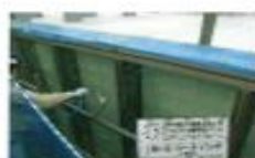
4 光触媒塗液塗布(M2-MVX-HG-T)
