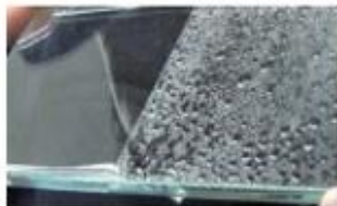
施工済 / 未施工
