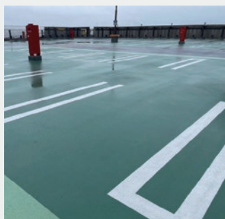
屋上防水工事
