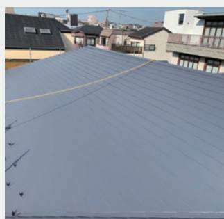
外壁塗装工事
