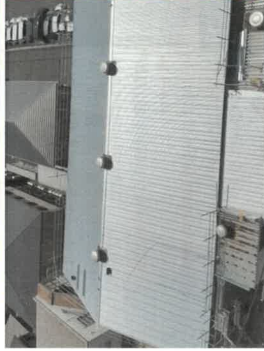
遮熱した上に新しい屋根材を施工
